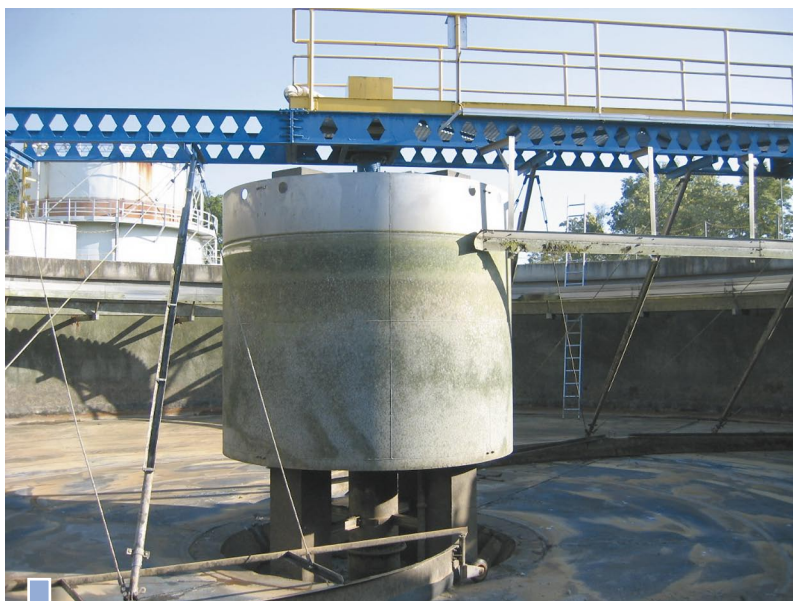
Fot. 4. Studnia i zgrzeblto zgarniacza osadu w osadniku wtórnym o przepływie pionowym
