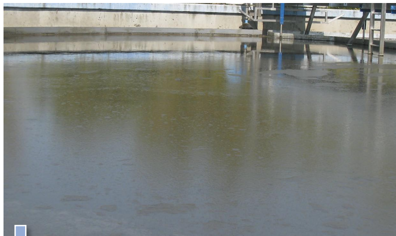
Fot. 1. Wtórna denitryfikacja – wynoszenie osadu czynnego w osadniku wtórnym pionowym
