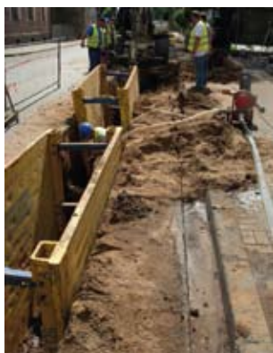
Rys. 4. Montaż kanalizacji podciśnieniowej (fot. archiwum autora)
