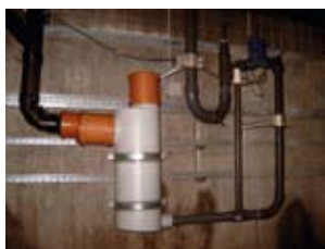
Rys. 3. Studnia zbiorcza z zaworem opróżniającym montowana w piwnicy [1]
