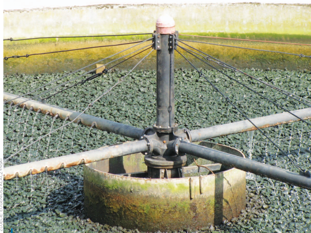
FOT. 1. Złożo biologiczne zraszane – wypełnione złożo koksem
